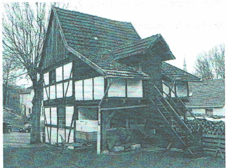
„Kneers Speicher“ (östliche Seite des Gebäudes mit Aufgang)
